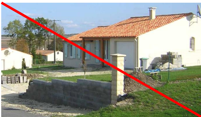
Mur en décrochement et pilier
