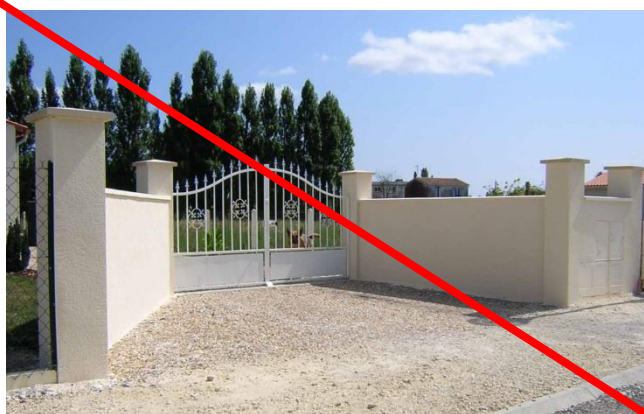
Piliers de portail en maçonneries imposantes sans lien avec la clôture (grillage).
