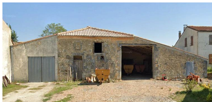
Grange assez bien conservée Chez Ravet. Les moellons ne sont pas enduits comme il est d'usage pour les dépendances et le bâti agricole.
