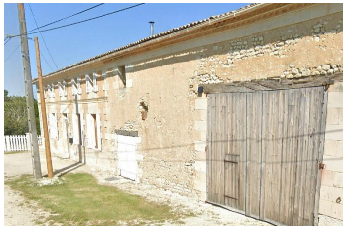
Maison rurale typique prolongée d'une dépendance agricole. A noter la couleur chaude et lumineuse de l'enduit traditionnel.
