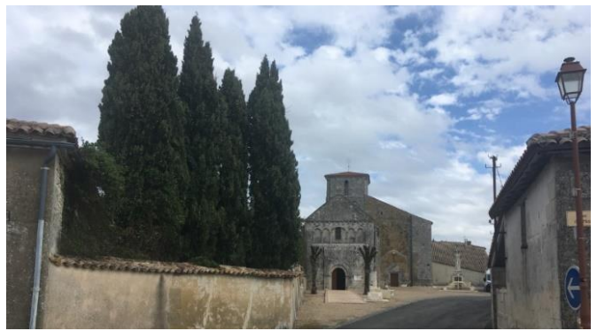
Vue sur l'église et la place du 11 novembre
